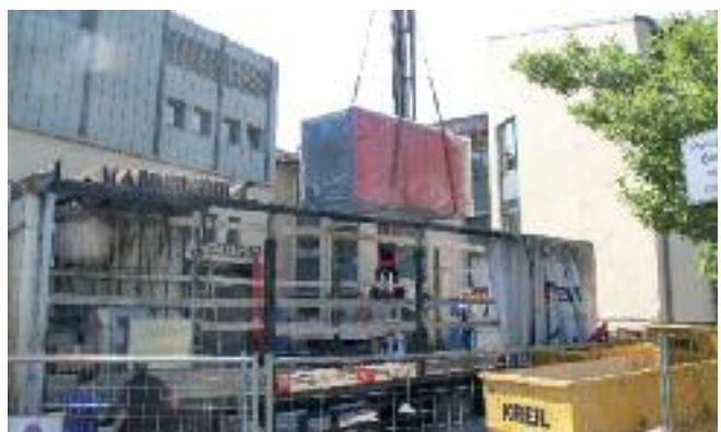
Recht aufwändig wurde die große Maschine in die vorgesehene Position „buchsirt“.
